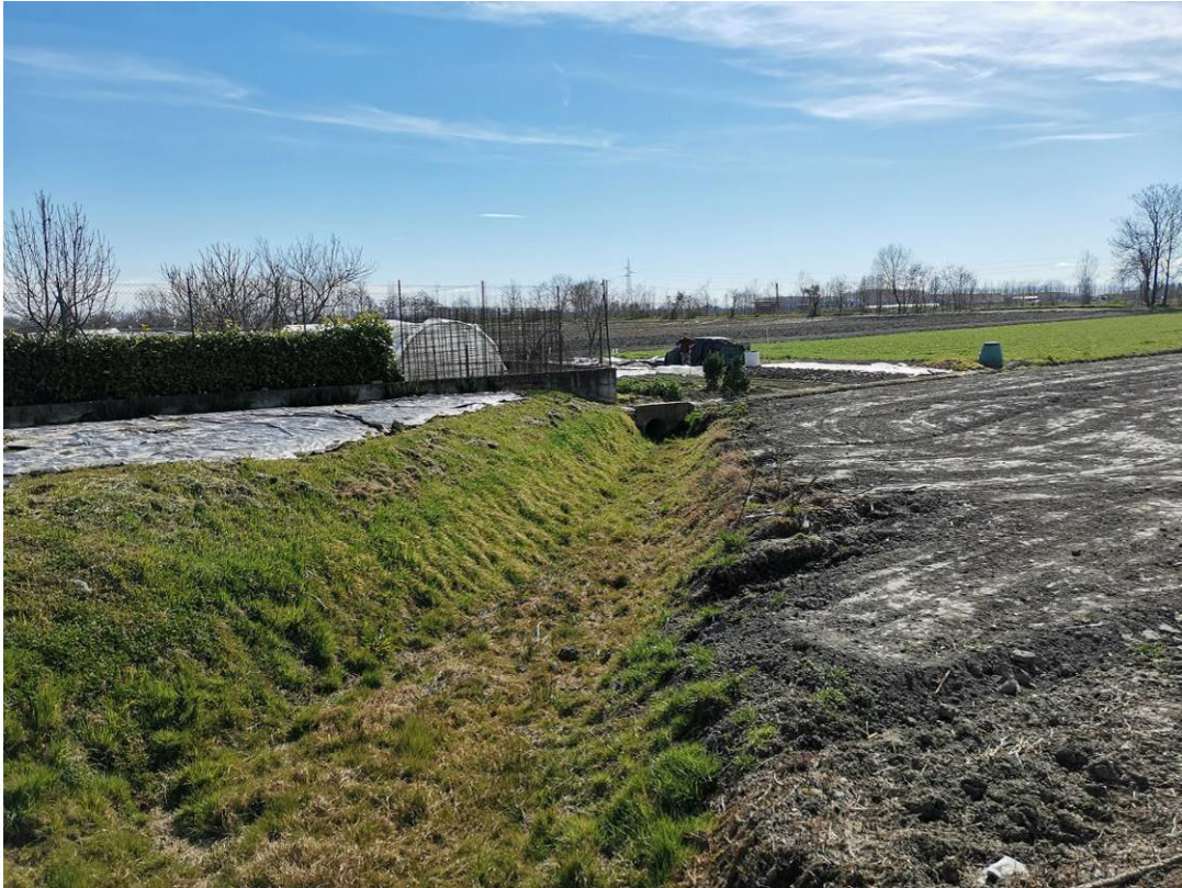
Immagine n. 4 – zona via Umberto I intervento 2: canale in terra a valle delle tubazioni di scarico oggetto di rifacimento ed ampliamento
