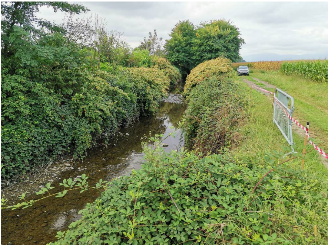
Immagine n. 9 – realizzazione scogliera intervento 3: vista della lunata erosiva sponda sx T. Lemina verso monte e tratto oggetto di pulizia sponde
