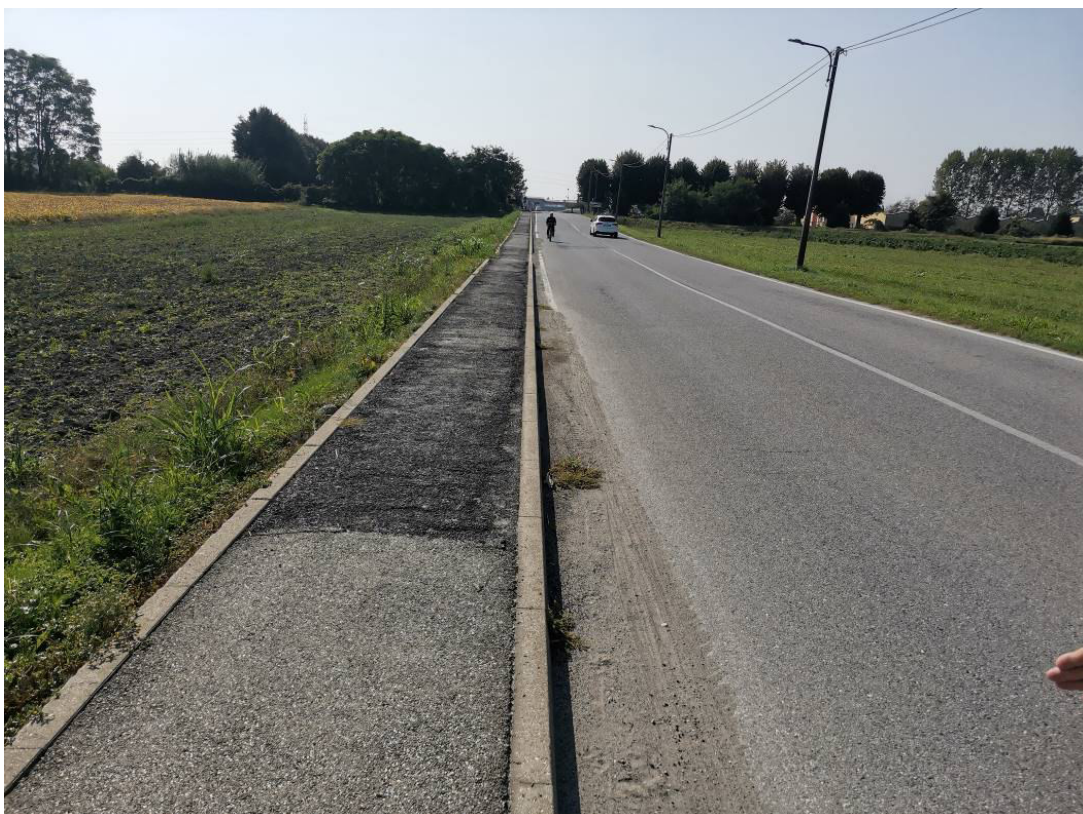
Immagine n. 6 – zona via Umberto I intervento 2: zona in cui è prevista la realizzazione di caditoie per smaltimento acque di piattaforma
