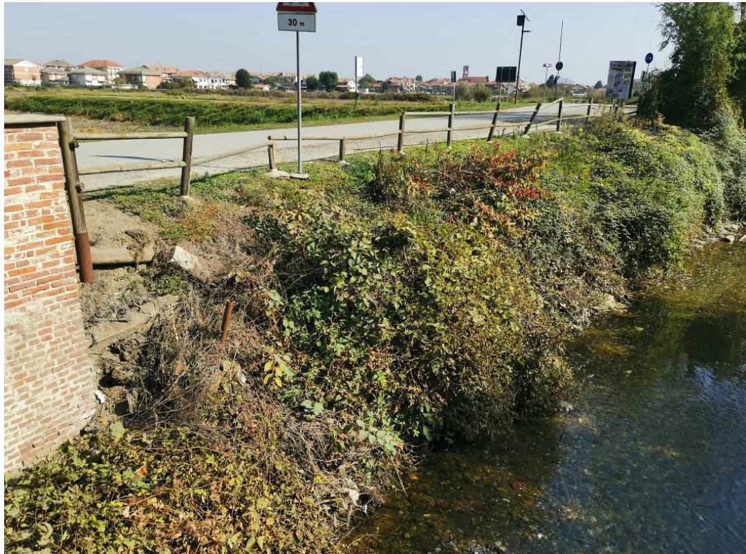
Immagine n. 13 – intervento 4: particolare parapetti esistenti in legno oggetto di rifacimento
