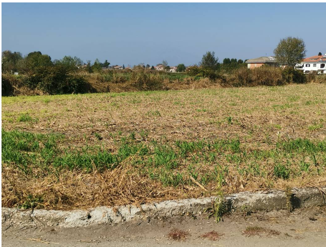
Immagine n. 10 – manutenzione argine esistente intervento 3: vista rilevato arginale in terra oggetto di pulizia e decespugliamento
