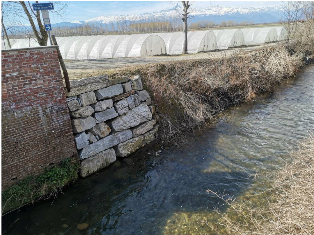
Immagine n. 12 – scogliera lungo il T. Lemina intervento 4: vista da monte della scogliera esistente a monte della quale è previsto il miglioramento dell'ammorsamento nella sponda
