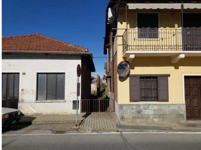
Figura 11.1.2: Parapetto esistente su Via XX Settembre
