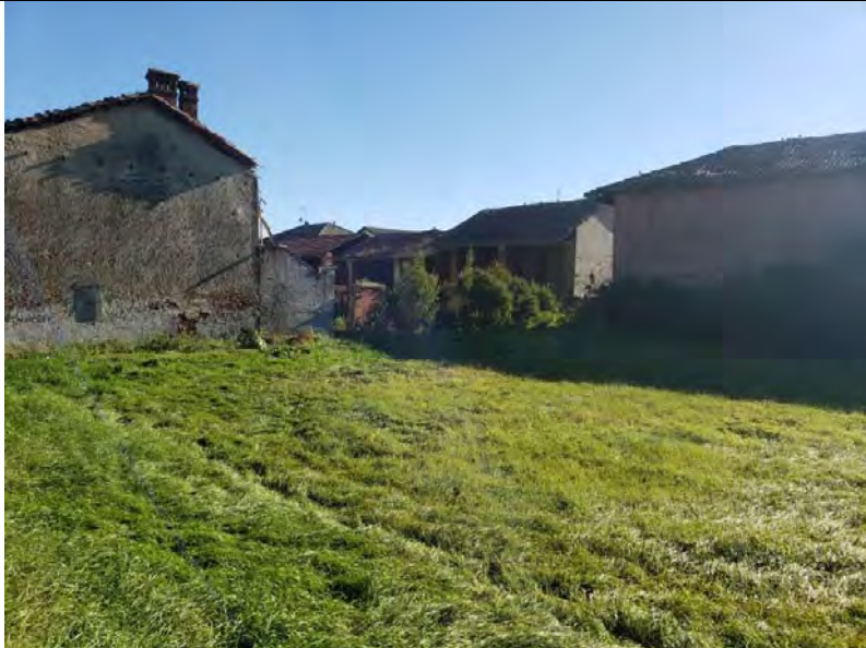
Figura 5.1.3: Inizio Gora comunale da Via circonvallazione – Area destinata ingresso cantiere
