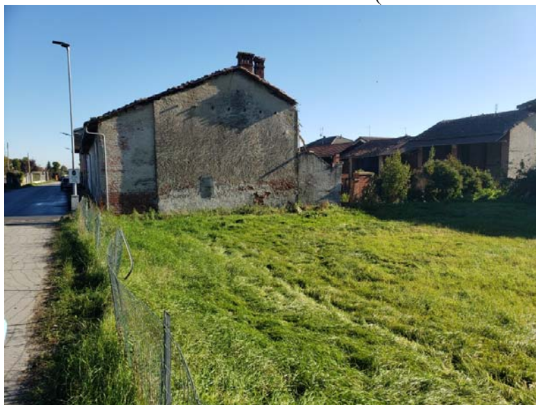
Figura 5.1.2: Inizio Gora comunale da Via circonvallazione – Area destinata ingresso cantiere.
