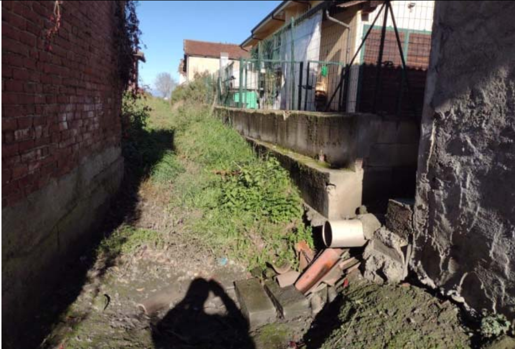
Figura 2.2.3: Tratto intermedio Gora. Inizio dei terreni prativi in sinistra (direzione di flusso dal basso verso l'alto).
