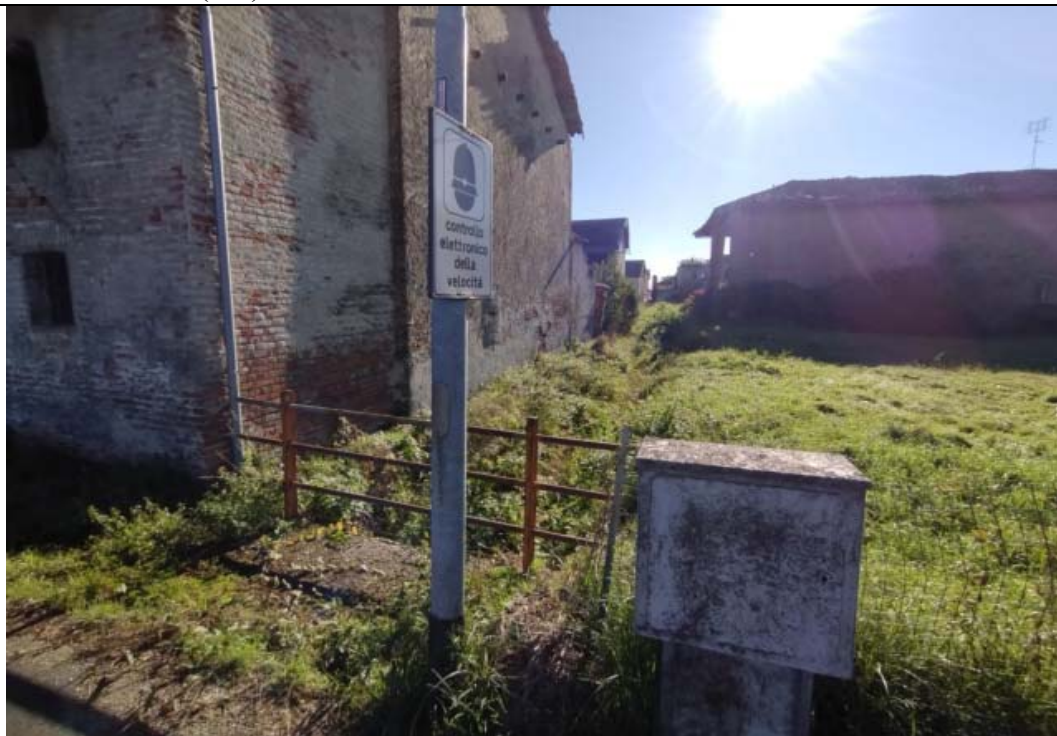
Figura 2.2.5: Immissione del canale al di sotto di via Circonvallazione (direzione di flusso dall'alto verso il basso).
