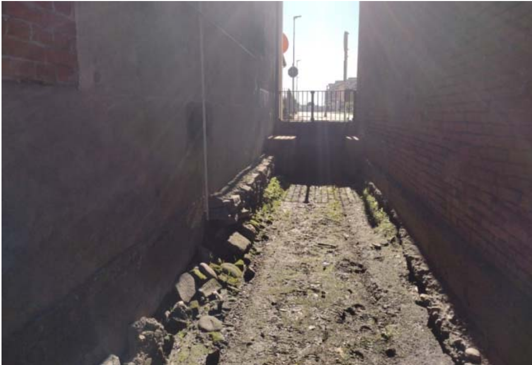
Figura 6: tratto iniziale della Gora a valle di via XX Settembre (direzione di flusso dall'alto verso il basso).
