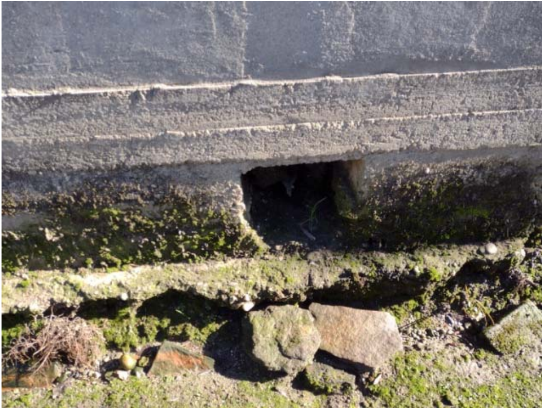
Figura 11: scarico di acque meteoriche in destra orografica (direzione di flusso da destra verso sinistra).
