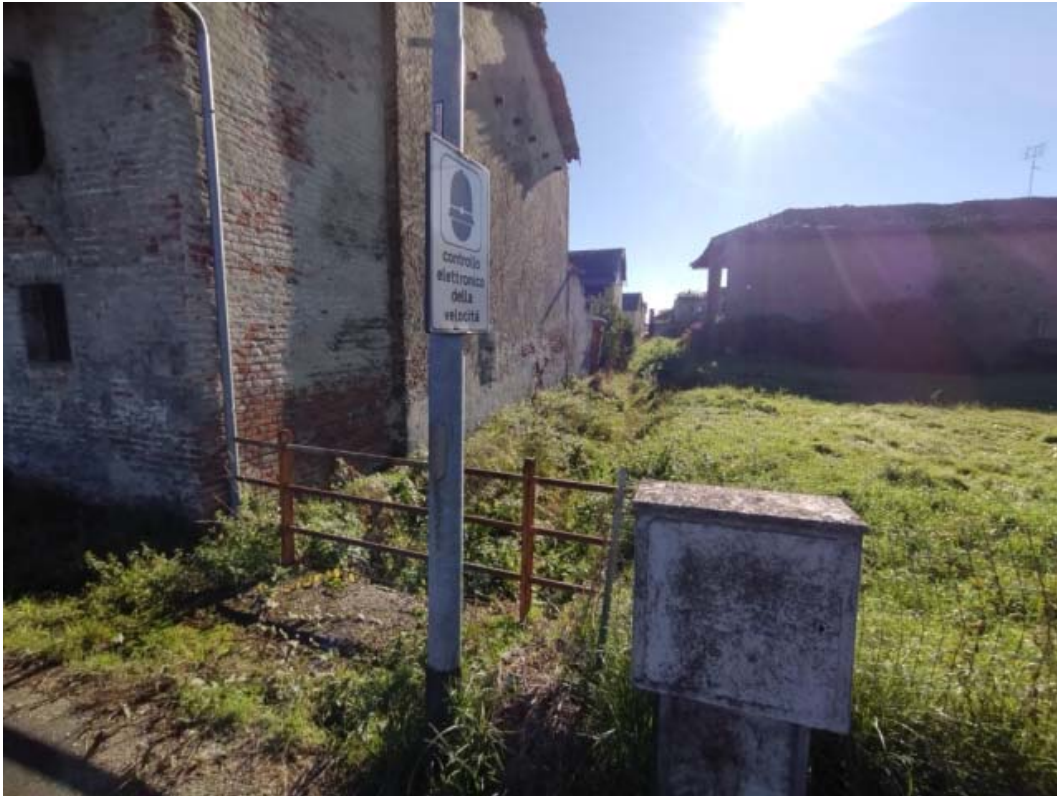
Figura 10: immissione del canale al di sotto di via Circonvallazione (direzione di flusso dall'alto verso il basso).
