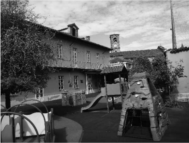
I fabbricati A e B visti dal cortile interno
