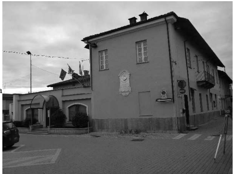
A fianco: il fabbricato B visto da Piazza Ceppi
